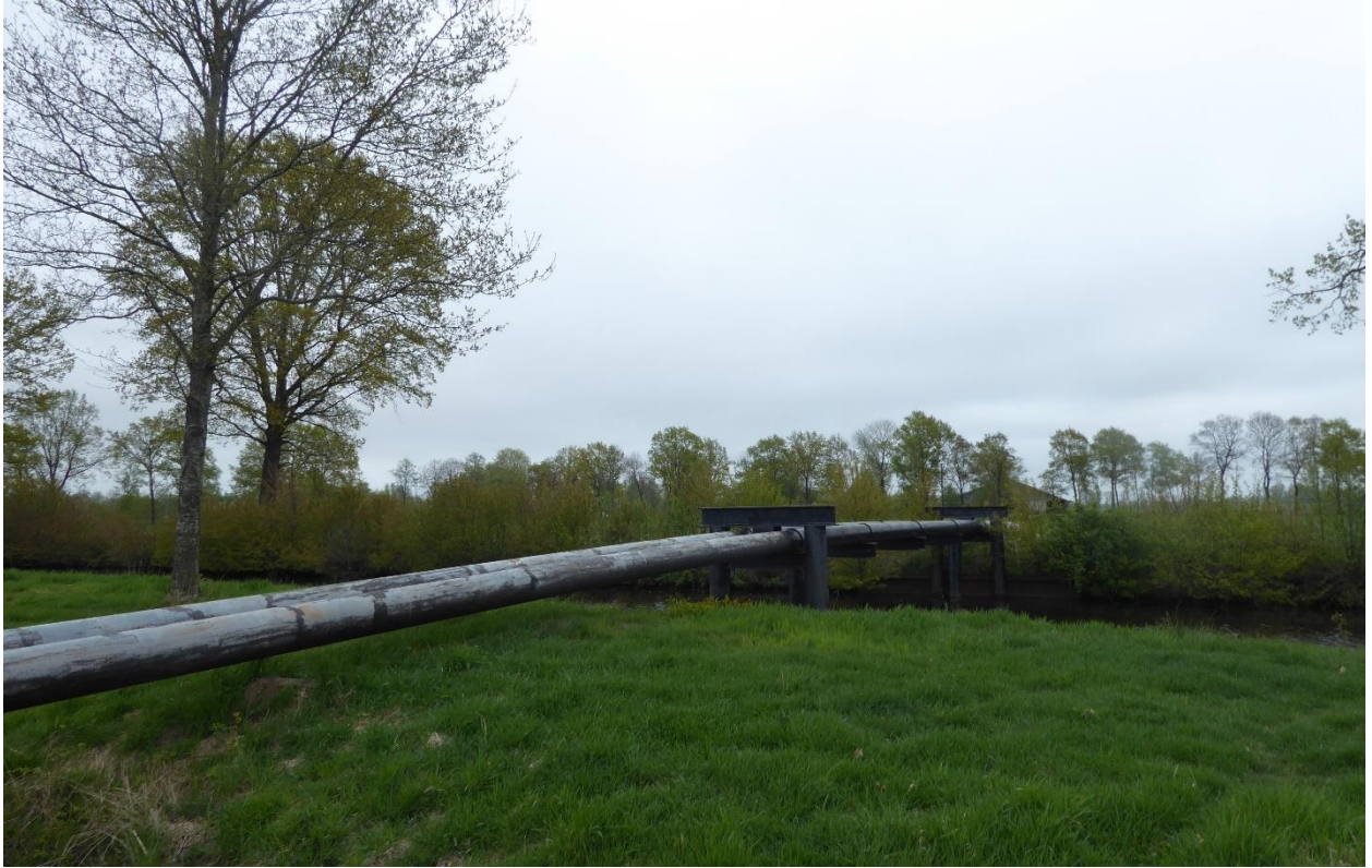
Blick von Westen auf die den Moorriemer Kanal querenden Gasleitungen
