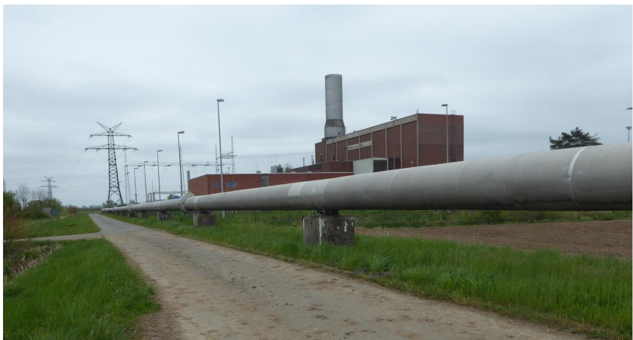
Blick von Norden auf das Druckluft-Speicherkraftwerk von Uniper mit oberirdischer Gasleitung
