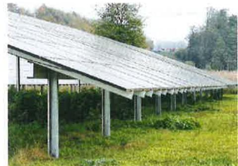
Die Module werden fest installiert. Die Gründung erfolgt mit Metallprofilen. Es wird extensiv begrünt. Flächen könnten bei Nichtvernässung teilweise, z.B. von Schafen beweidet werden.
