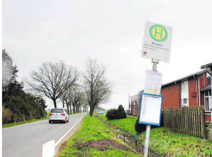
Bei Mode W in Bardenfleth wird an der K 213, Nordermoorer Hellmer, eine neue Bushaltestelle gebaut. BILD: MERLE ULLRICH
