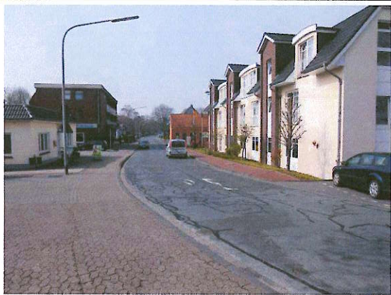
Hafenstraße – technische und gestalterische Mängel
