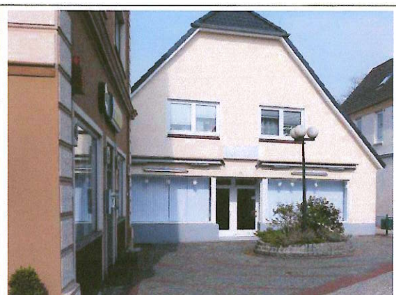
leerstehendes Ladenlokal in der Steinstraße
