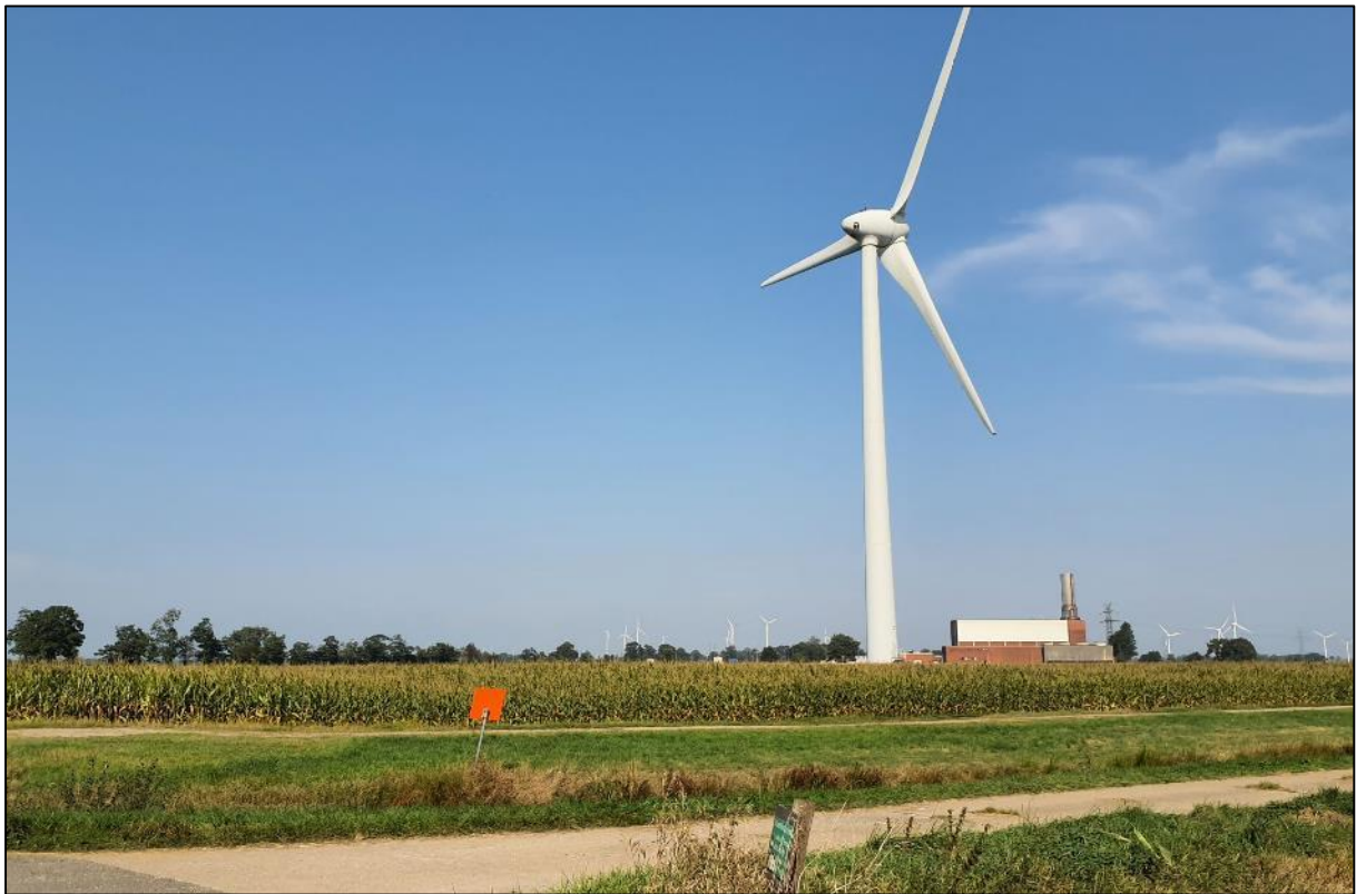
Abb. 3: Blick nach Norden auf das Kraftwerk Huntorf mit Bestandsanlage
