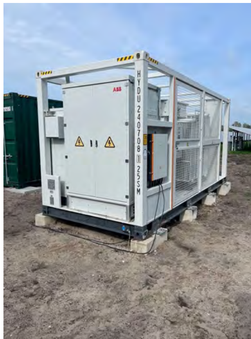
Abbildung 2: Mögliche Bauweise einer Transformatorstation auf Betonpfählen
