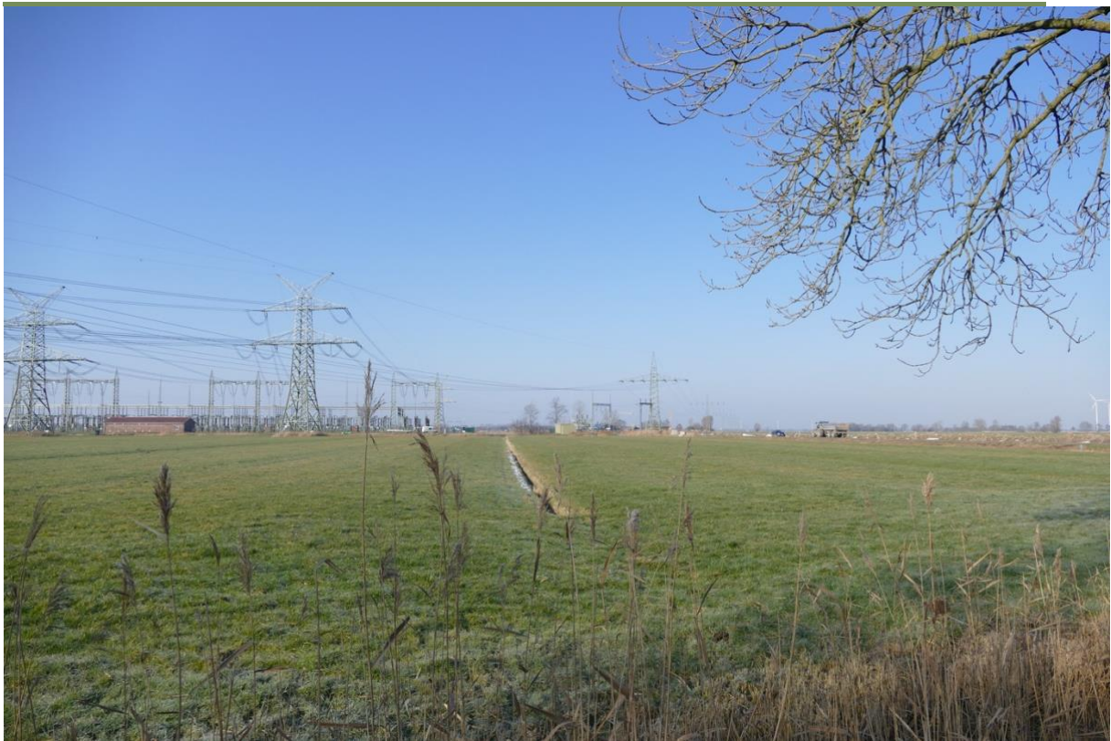
Blick in süd-westlicher Richtung des Untersuchungsgebietes auf das Überspannwerk
