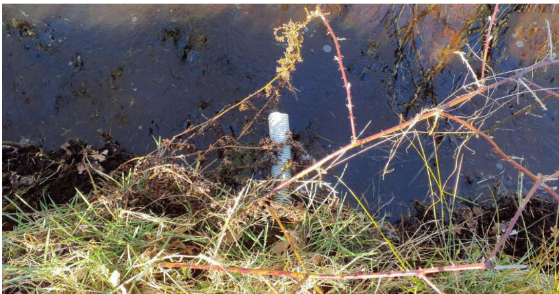
Abbildung 4: Auslass einer Kunststoffdrainage in das Grabennetz
